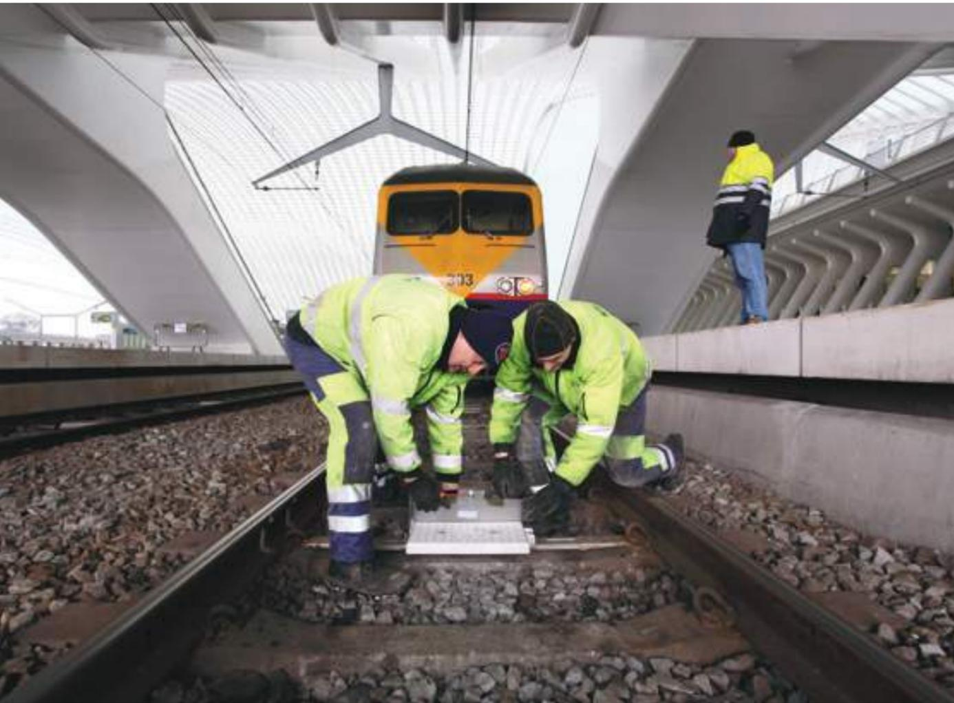
Installation du nouveau système ERTMS/ETCS - gare de Guillemins - Liège (BE)
